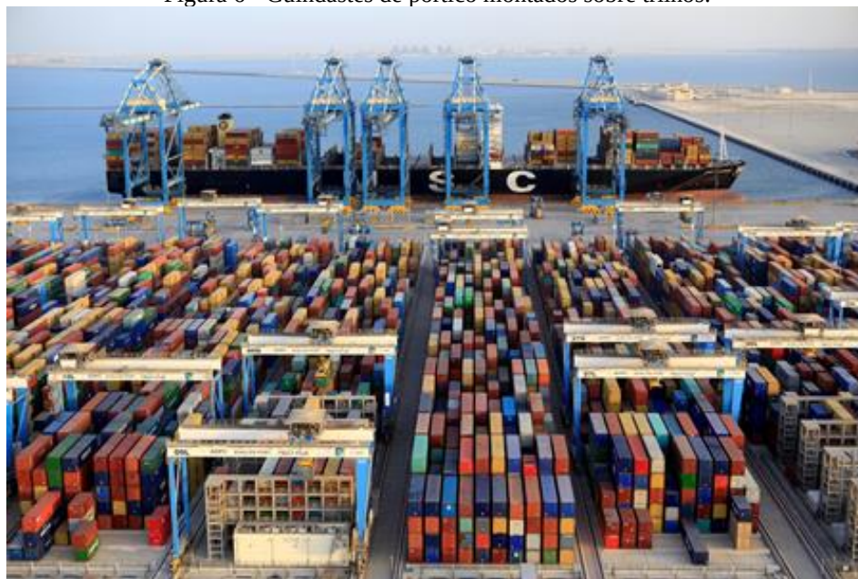
Figura 6 - Guindastes de pórtico montados sobre trilhos.
