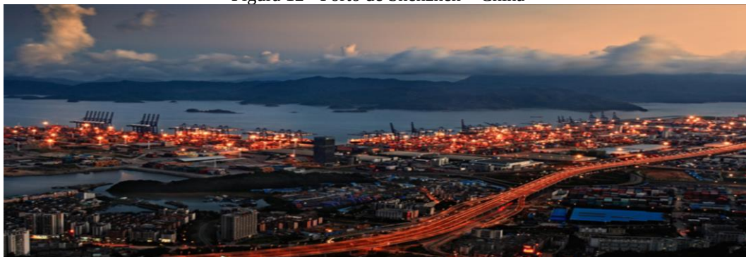
Figura 12 - Porto de Shenzhen – China
